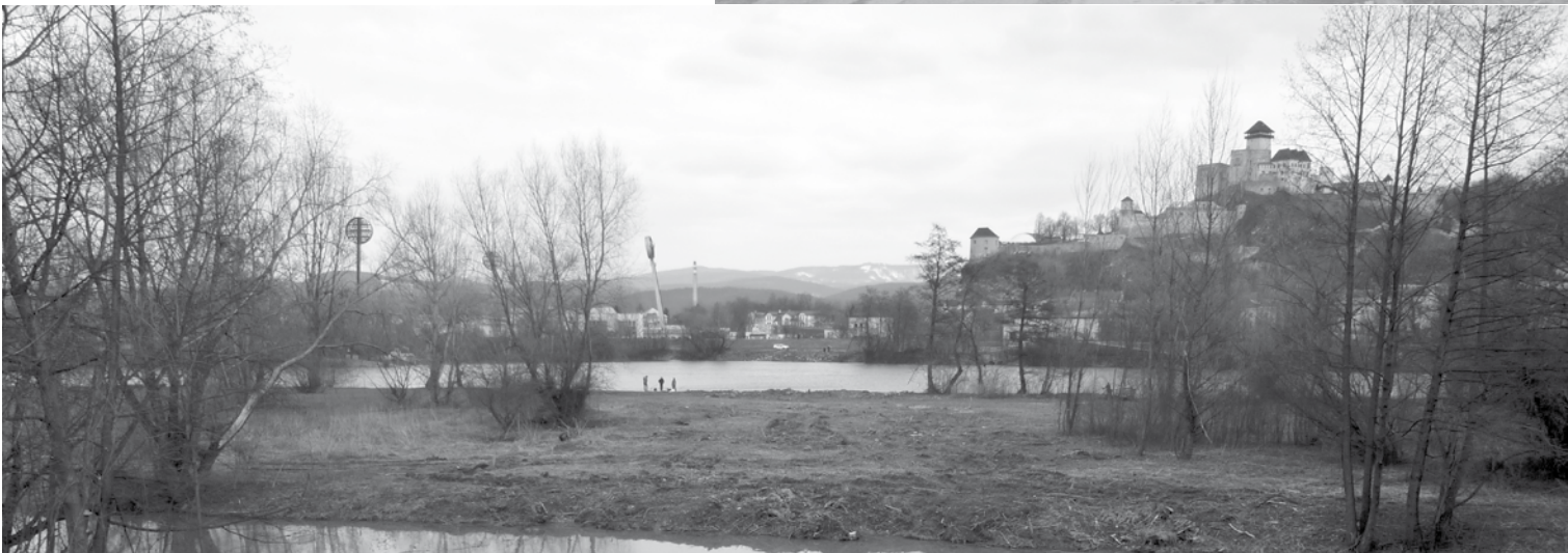
Týmto priestorom sa bude tiahnuť nový železničný most.
